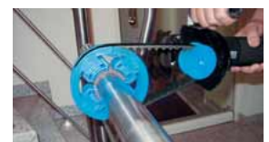
Zerkratzte Handläufe nachschleifen.
