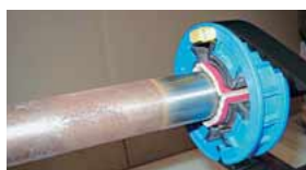
Rohre entrosten und reinigen.
