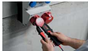
Spannungsprüfung bei CEE-Steckdose
